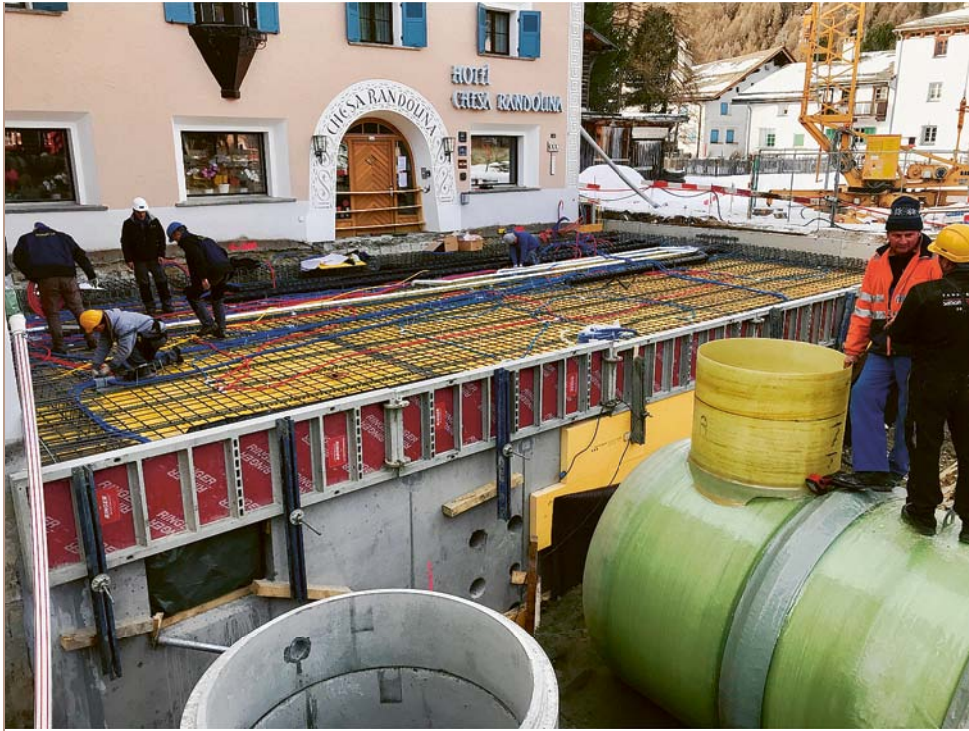
Im Untergrund entstehen verschiedene Wirtschaftsräume
