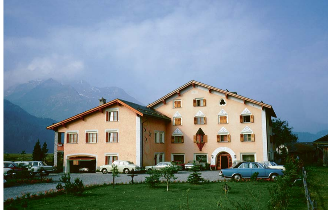
1969: die Erweiterung des Wohnbereichs für die sechsköpfige Familie steht
